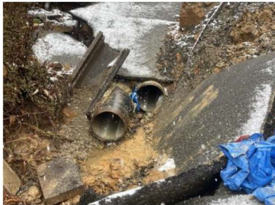
NS形ダクトイルφ400(輪島市)
