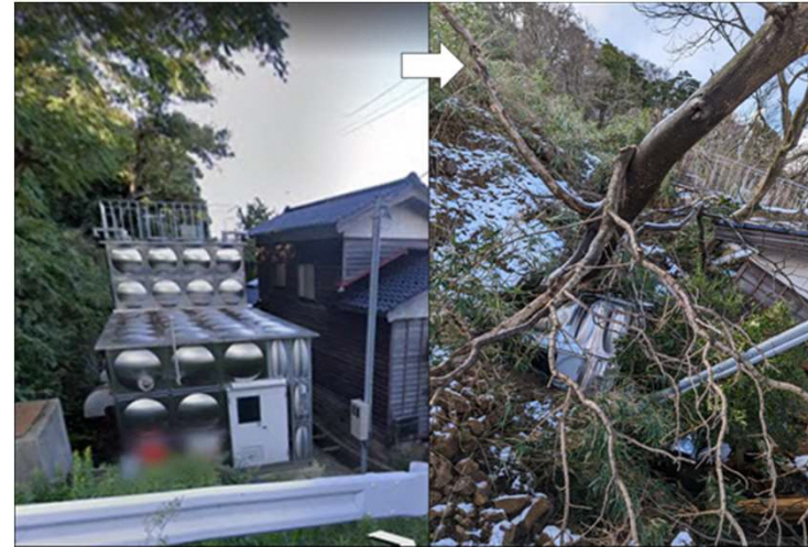
稲船ポンプ所損壊(輪島市)
