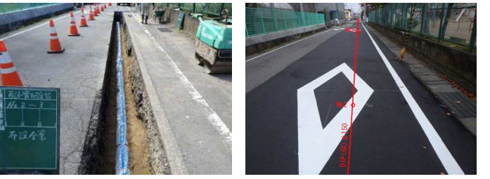
R3 米代一丁目 配管・舗装
