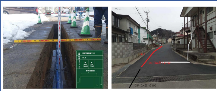
R3 八角町 配管・舗装状況
