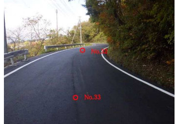
R3 一箕町八幡 舗装 (R2配管施工箇所)
