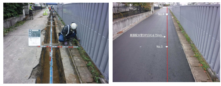
R3 桧町 (1工区) 配管・舗装状況
