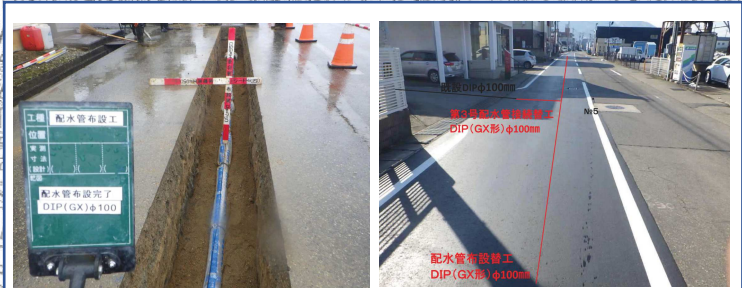
R3 桧町 (2工区) 配管・舗装状況
