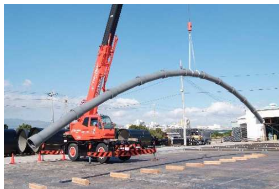
耐震管をクレーンで吊っても継手が抜けない
