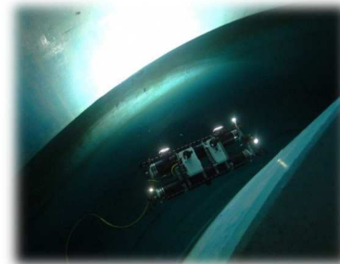
水域ドローン（気中部）による 受水塔水槽内部撮影
