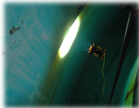
水域ドローン（水中部）による 受水塔水槽内部撮影
