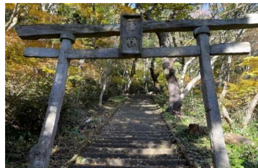
参道と参道の途中に設けられた石鳥居
