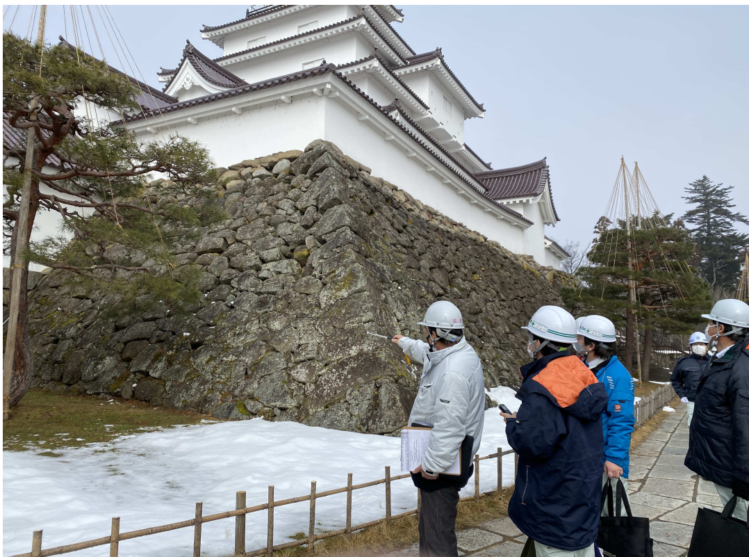
現地実査 令和5年1月13日 工事現場内での質疑応答状況
