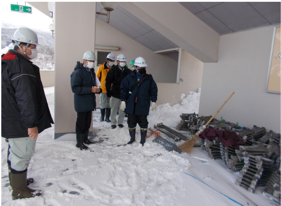
現地実査 令和4年1月14日 観覧席再使用脚部の確認
