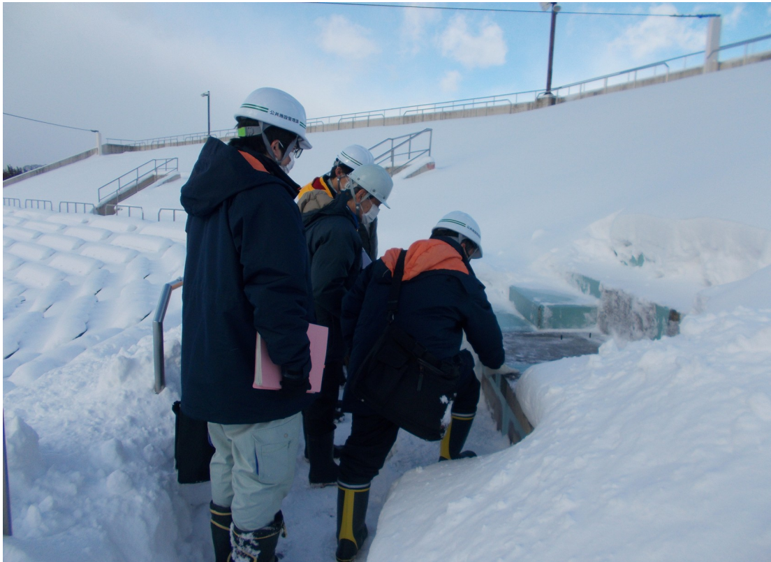
現地実査 令和4年1月14日 防水工事施工部分の説明
