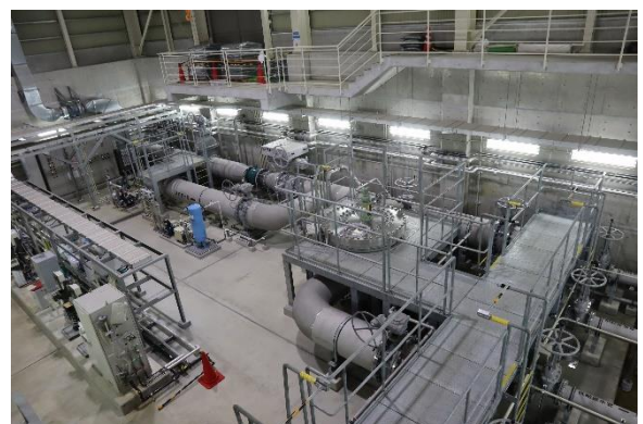
滝沢浄水場内
