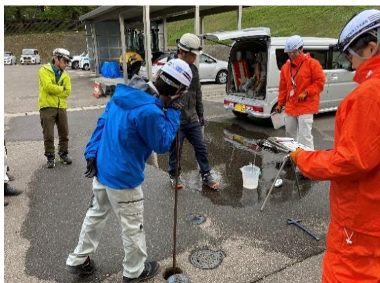
技術力向上を目的とした仕切弁操作講習会
