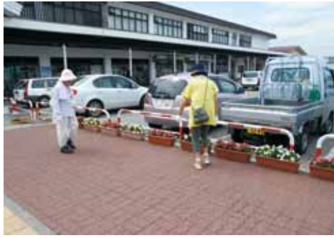
プランター設置作業の様子
