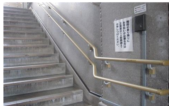
中央階段手すり (本庁舎旧館)
