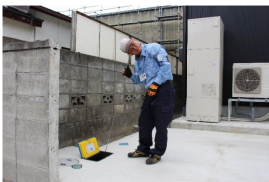
写真9 漏水調査状況
