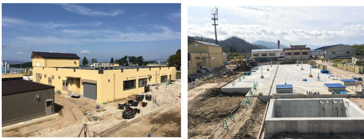
写真4 更新工事中の滝沢浄水場（平成28年度）
