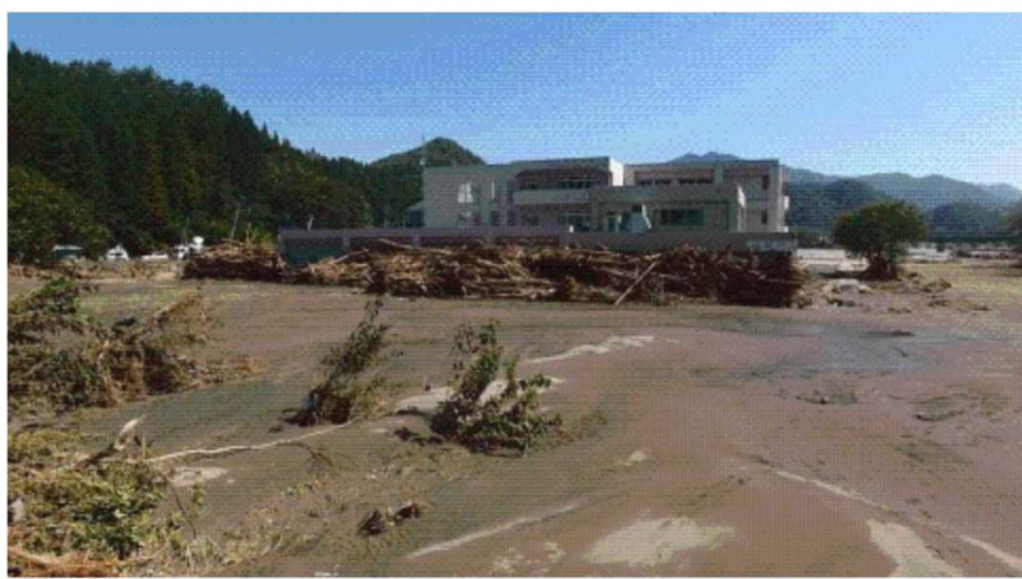
平成28年台風第10号による被害状況
