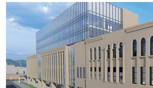
高層部はガラス張りの カーテンウォール
