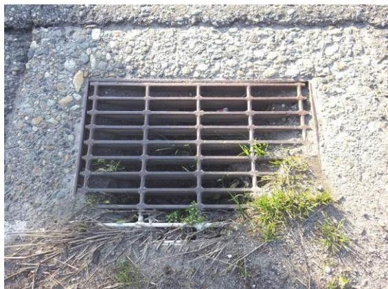
国道 118 号沿いの道路側溝（土砂堆積）
