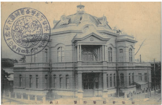
1911(明治44)年ごろに製作された「新築若松警察署」の絵はがきです。左上には、開庁式の日付と旭日章がデザインされたスタンプが押してあります
