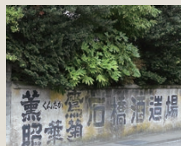
通りに面したブロック塀がレトロな雰囲気を醸し出しています
