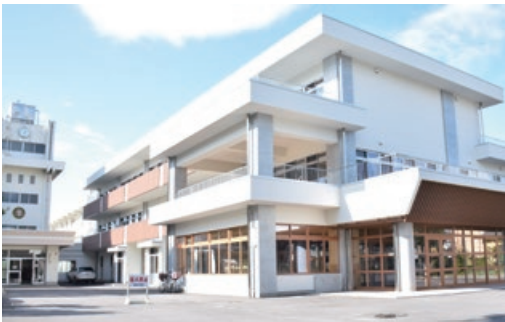
城北小学校の北東棟が完成しました
