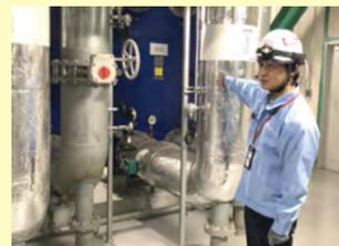
工場から出た熱はこの熱交換器で回収し、暖房に利用しています
