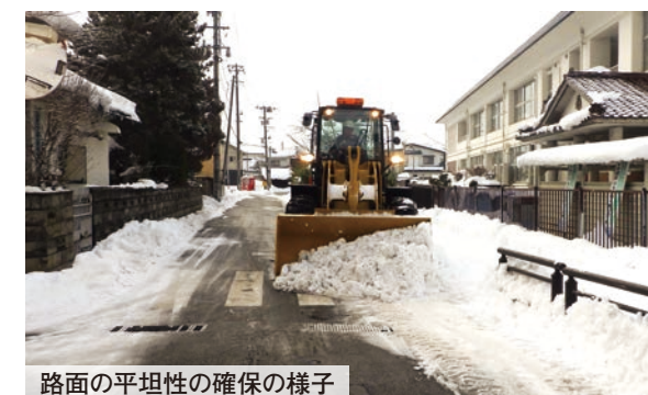
路面の平坦性の確保の様子
