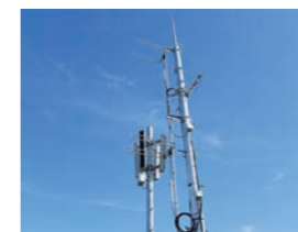
市役所本庁舎の屋上にアンテナを設置しました
