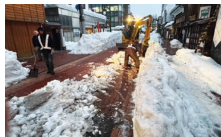
厚くなった路面の圧雪を取り除きます
