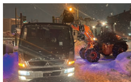
道路端に寄せられた雪を積み込みます
