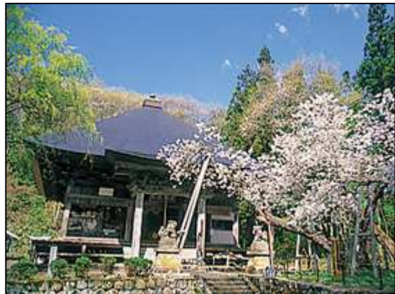
28 法用寺観音堂 (会津美里町)
