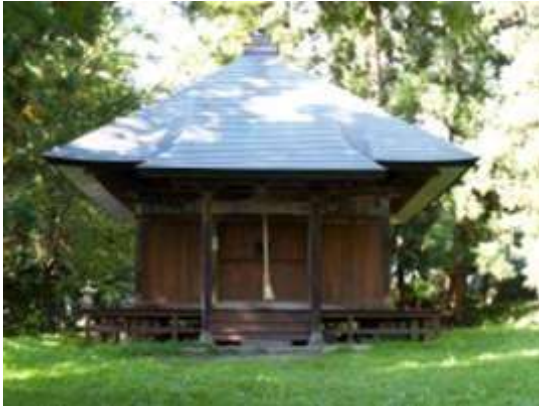
7 慧日寺 薬師堂 (磐梯町)
