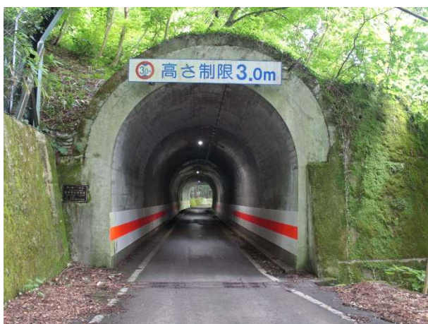
芦ノ牧トンネル
