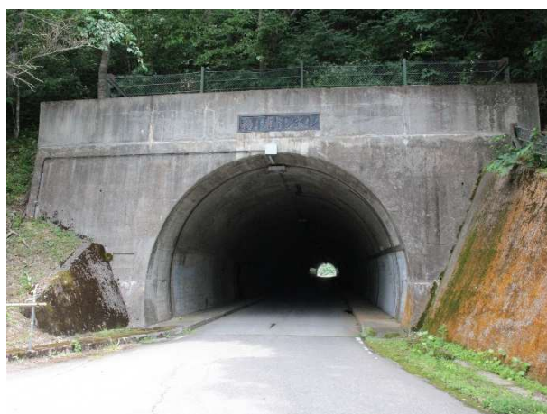
鵜ノ浦トンネル
