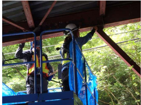
写真 4.7 鋼部材の触診
