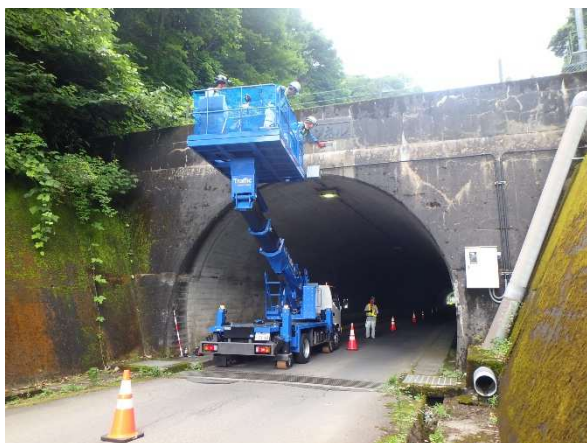
写真 4.2 高所作業車による点検
