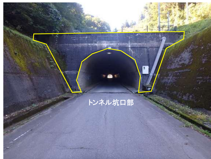
写真 4.1 トンネルの点検対象箇所
