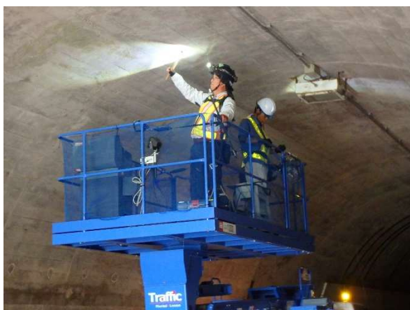
写真 4.4 打音検査
