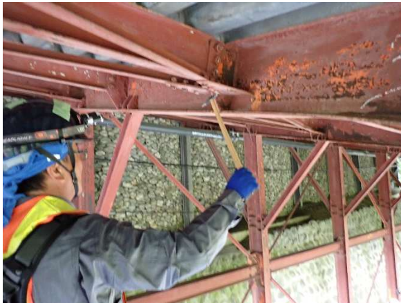
写真 4.6 接合部の打音検査
