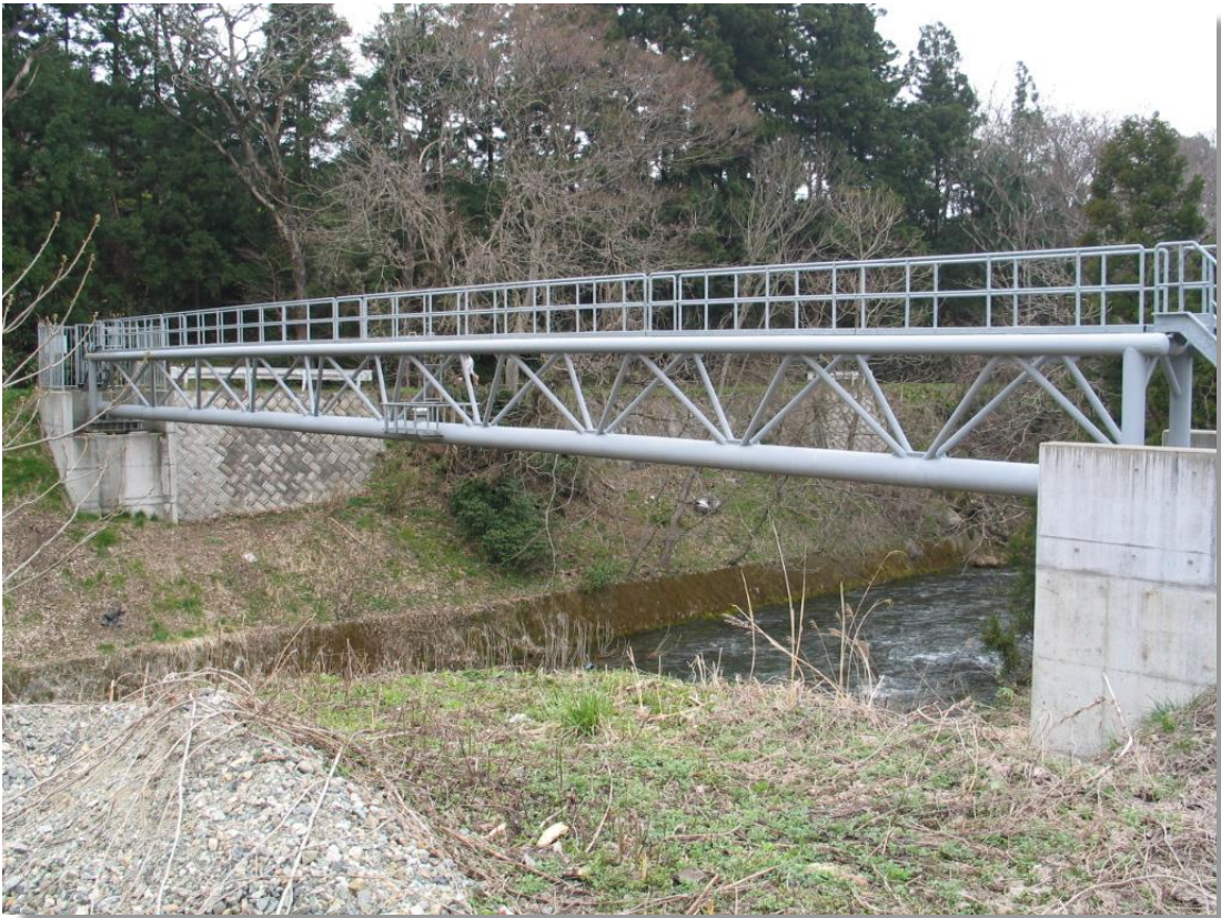
東山町地内の院内水管橋
