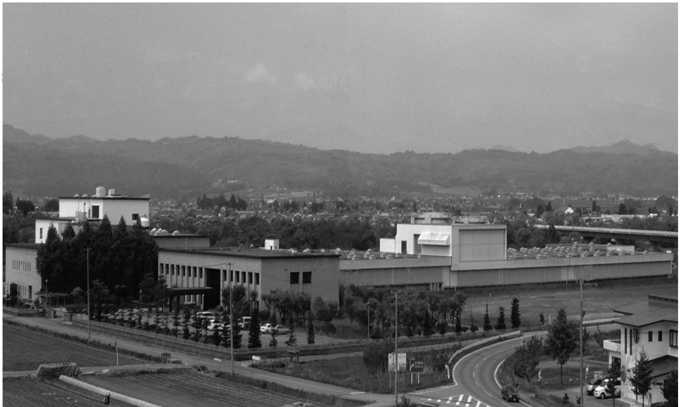
会津若松市下水浄化工場
