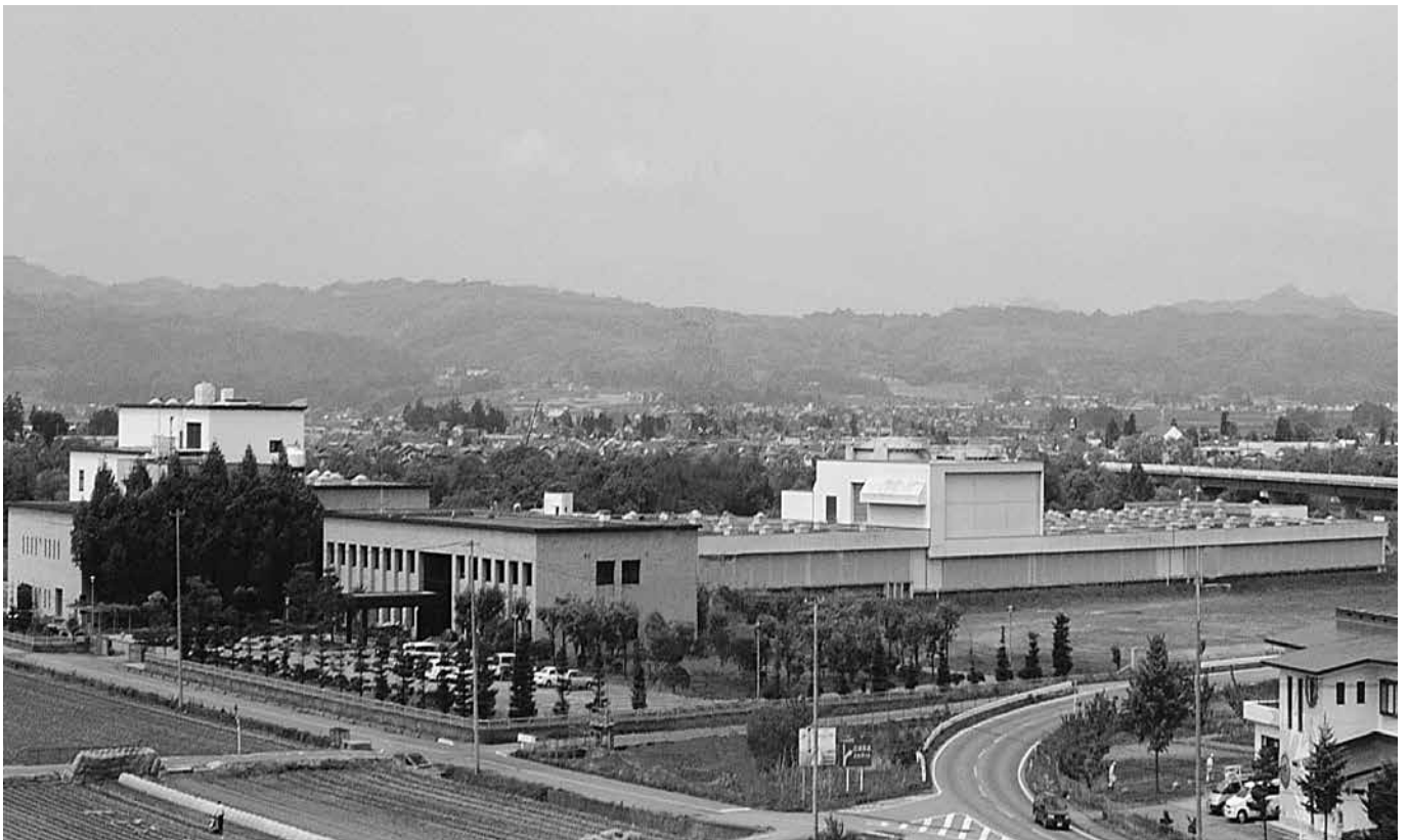
会津若松市下水浄化工場
