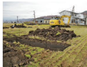
▲重機を使って慎重に掘削作業を行います。
