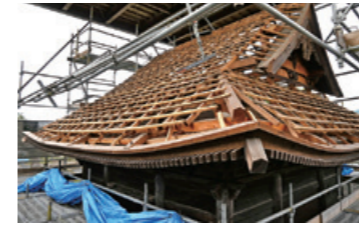
▲(上)工事前 (下)工事中
