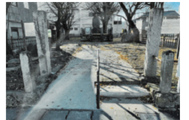
▲整備工事後の様子
