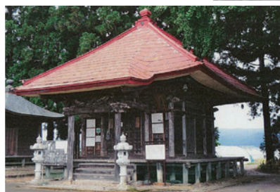
修復前の観音堂
