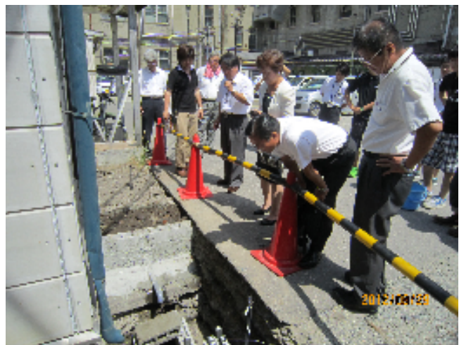
本庁舎中庭に雨水浸透枡を設置（H24年8月）
