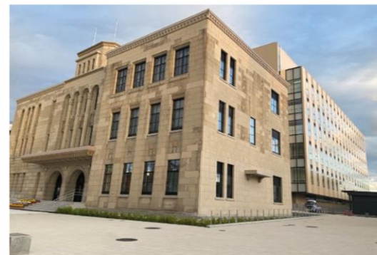
新庁舎北側旧館
