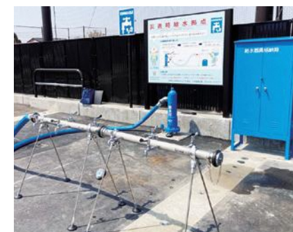
災害時給水栓（組立後）
