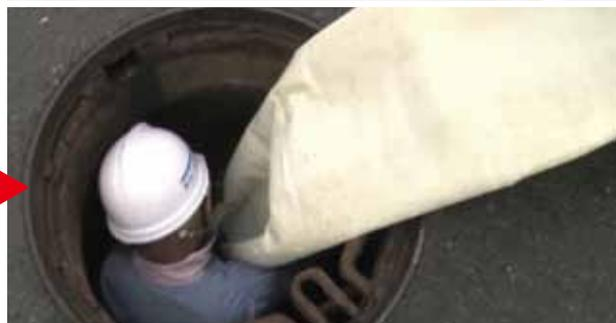
ホースの先端に専用の治具を取り付け、管の中にひきこんでいきます。
