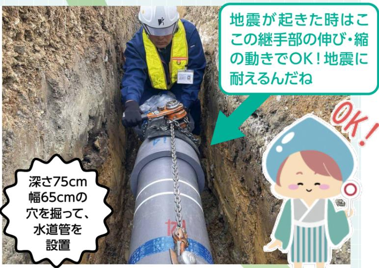
深さ75cm 幅65cmの穴を掘って、水道管を設置
