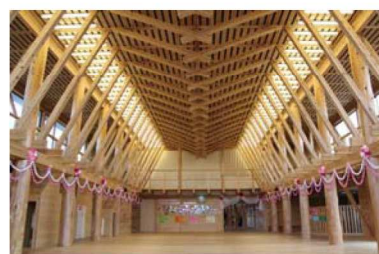
建築主・建設現場
