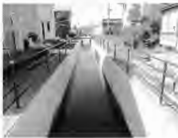
蟹川堀川水路整備工事 竣工後
