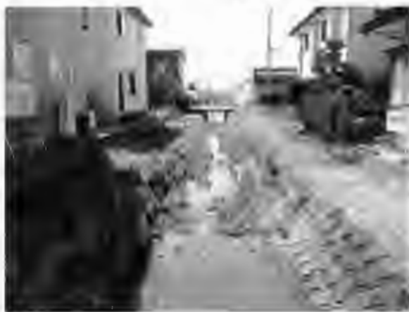
蟹川堀川水路整備工事 施工前
