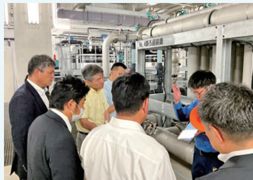
浄水場施設の視察の様子
