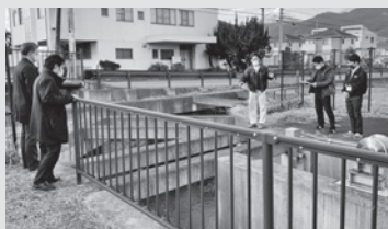
建設委員会の行政調査の様子 (静岡県沼津市 R6.1.18)
