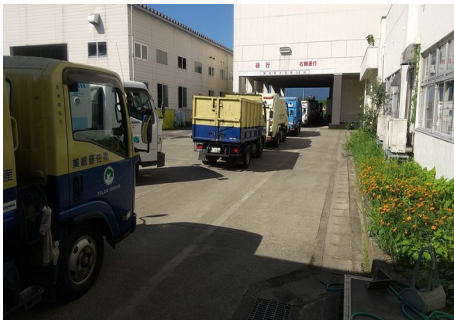
ごみ焼却施設
