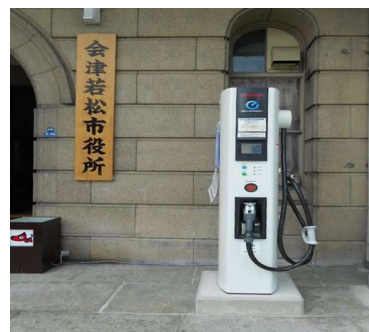
電気自動車・プラグインハイブリッド車、充電設備の普及の推進（市役所本庁舎正面電気自動車用急速充電器）
