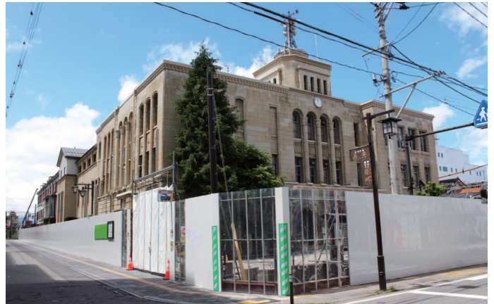
【本庁舎旧館を残し、解体工事を進めています】
