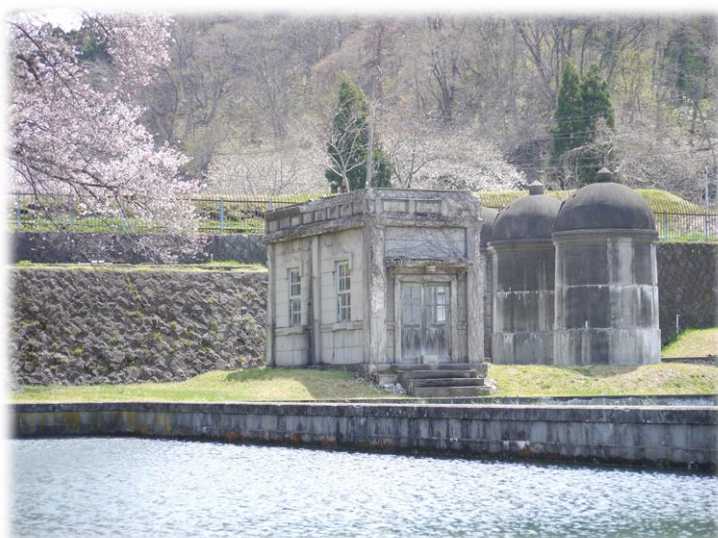
(滝沢緩速沈澱池と初期計量室)
