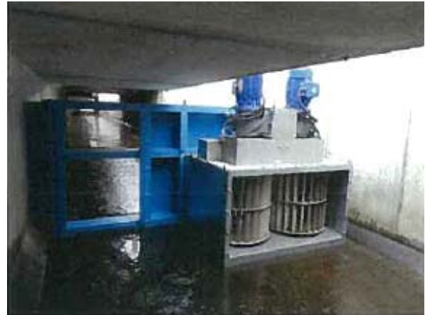
設置状況(例)写真
