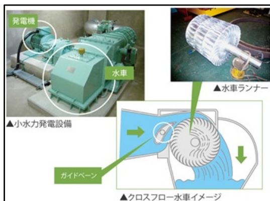
クロスフロー水車 (横軸タイプ)
