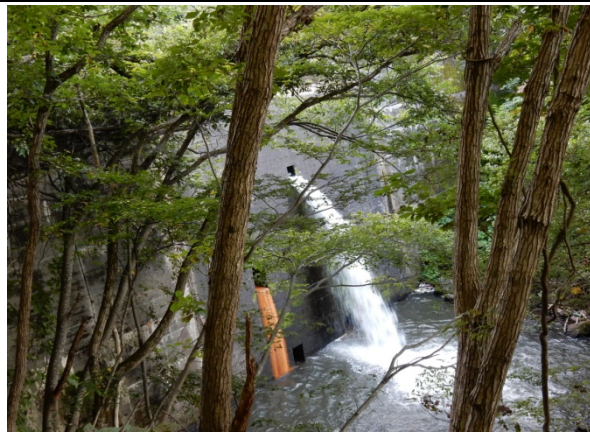
大工川第1号砂防堰堤（近景）
