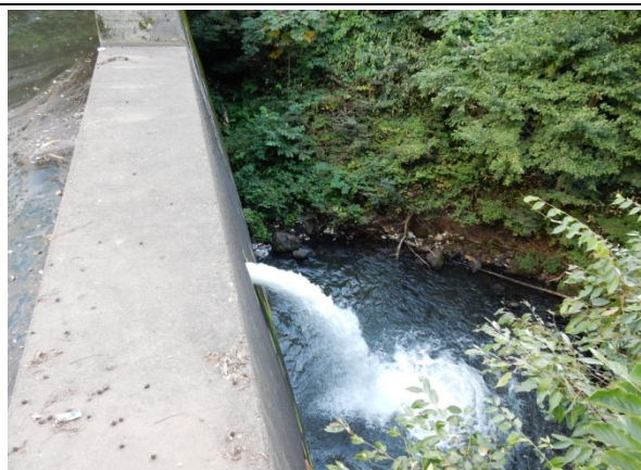
砂防堰堤（水抜き穴）からの流水状況
