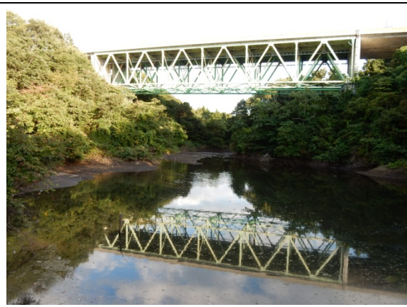
砂防堰堤上流側の湛水状況
