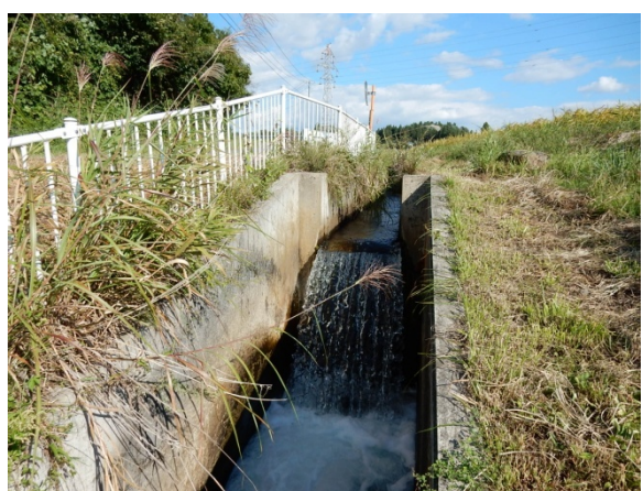
急流工下流部の落差工
