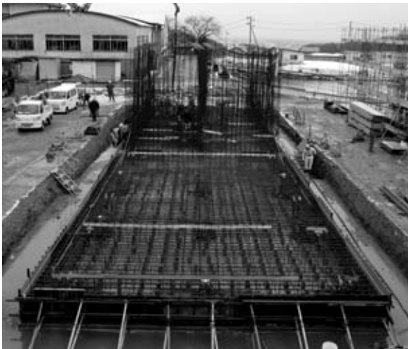
滝沢浄水場の施設耐震化
