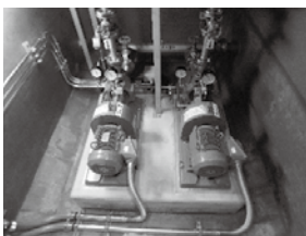
施工後(地下埋設型ポンプ室)
