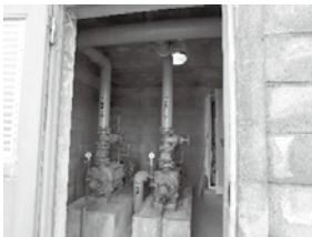
施工前(コンクリートブロック積みポンプ室)
