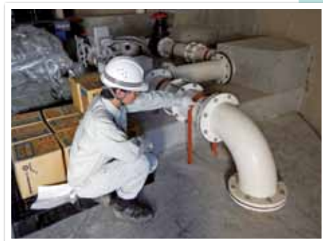
配水池での点検の様子
