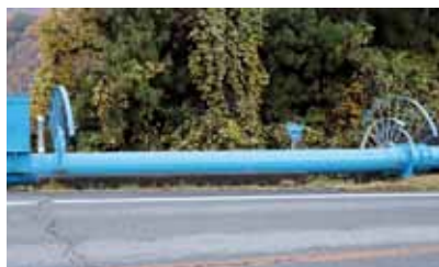
大戸町(沢川水管橋)
