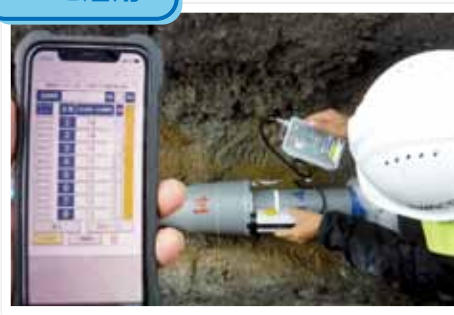
スマホで工事の進捗状況を記録
