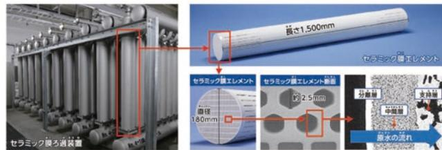
約0.1マイクロメートル(1万分の1ミリメートル)のとて、も小さな孔に原水を通して、小さな汚れを取り除きます。
