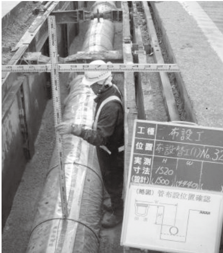
水道管の埋設工事の状況
